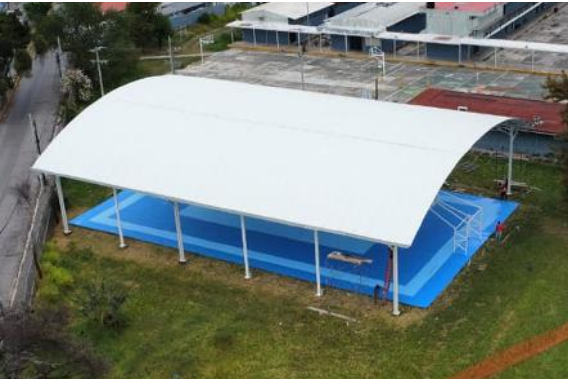
Construcción de techumbre metálica en cancha de usos múltiples en la Unidad Académica Preparatoria No. 1
