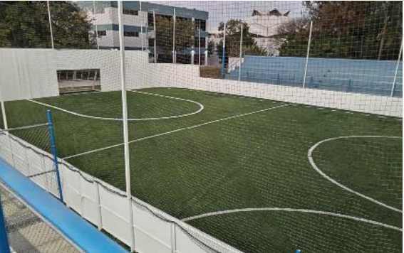
Rehabilitación de canchas de futbol rápido y cancha de usos múltiples en áreas deportivas de la UAN
