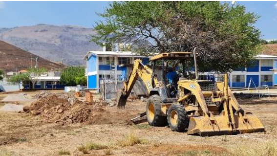
Rehabilitación de red sanitaria en la Unidad Académica de Ixtlán del Río
