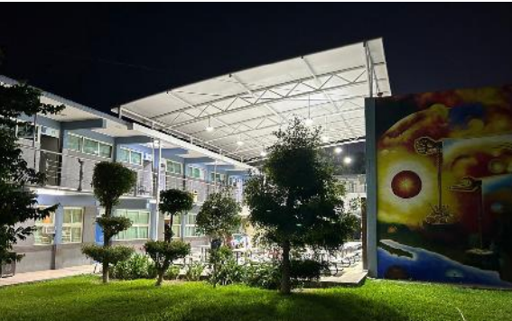
Techumbre metálica para espacio común en la Unidad académica de Contaduría y Administración
