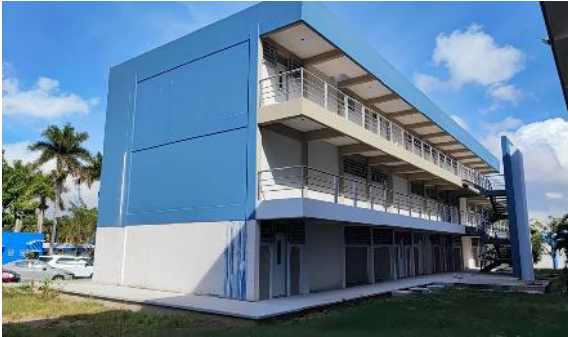
Edificio para laboratorios (tercera etapa) en la Unidad Académica de Ciencias Químico Biológicas y Farmacéuticas
