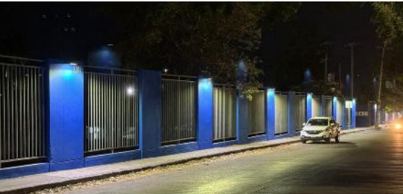
Instalación de lámparas led en exteriores de la Universidad
