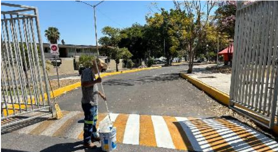
Mantenimiento en tráfico en vialidades de la universidad
