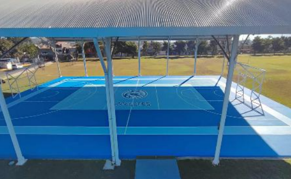
Rehabilitación de canchas de futbol rápido y cancha de usos múltiples en áreas deportivas de la UAN
